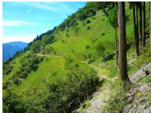
治山工事を行った森林
